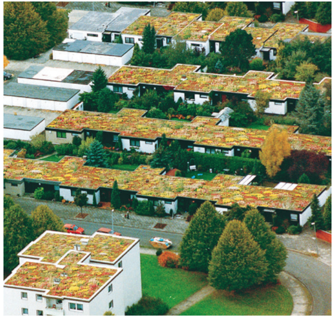
Viviendas adosadas, Wolfsburg
